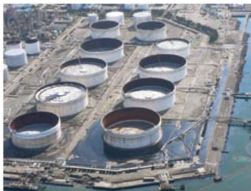
津波により屋外タンク貯蔵所の配管が破損しタンク内の危険物が流出した状況 (仙台市消防局提供)
