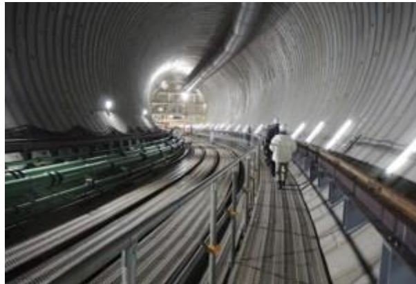
トンネル内の様子
