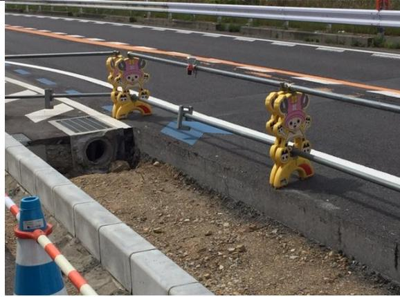
趣味のサイクリング中に気になって一枚。工事中の柵ですが、最近はやりのキャラクターの形状に加工された土台を用いています。鉄パイプを通す部分を広げると重量を支える強度が減る、でもキャラクターのデザインと合うように仕上げないといけない、これもある種のエンジニアリングと言えるでしょう。（PE-0253 西久保東功）
