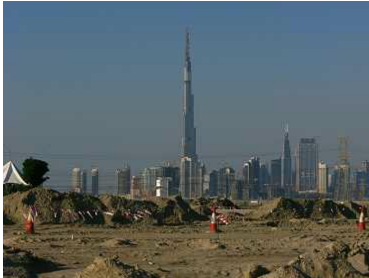
建設中のブルジュ・ドバイ（2008年12月）
