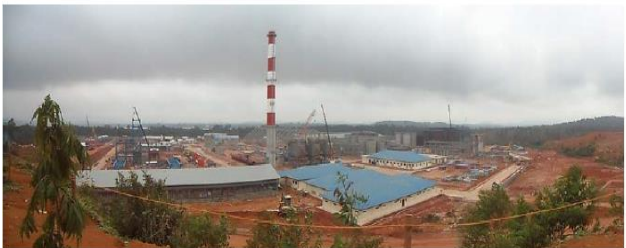
図1 建設現場全景
