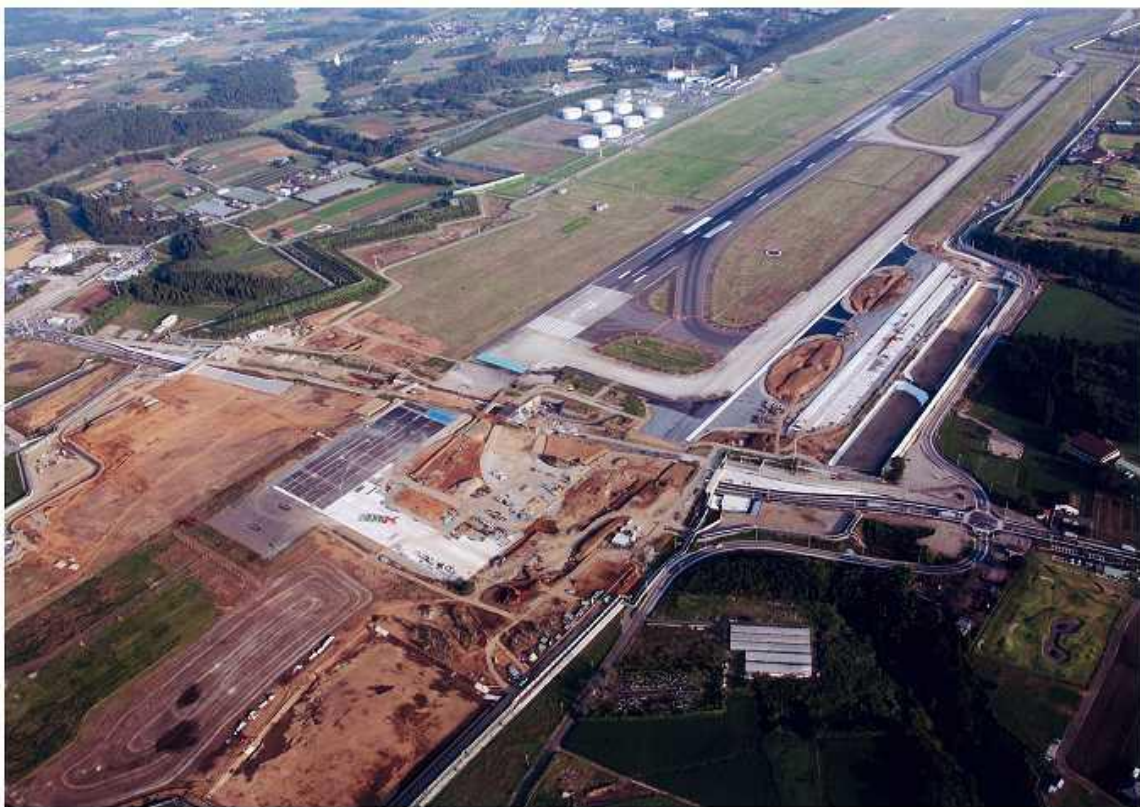
写真： B 滑走路延長工事（北西）
