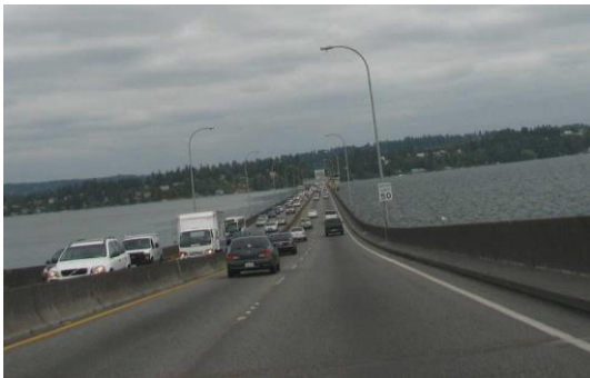
シアトルの浮き橋
