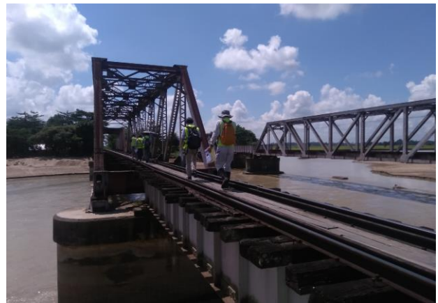
写真-1 路線中間の Swa 駅付近の橋梁既存軌道の調査風景
