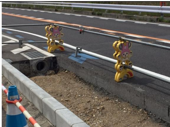
趣味のサイクリング中に気になって一枚。工事中の柵ですが、最近はやりのキャラクターの形状に加工された土台を用いています。鉄パイプを通す部分を広げると重量を支える強度が減る、でもキャラクターのデザインと合うように仕上げないといけな、これもある種のエンジニアリングと言えるでしょう。(PE-0253 西久保東功)
