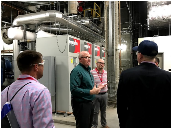
ガスボイラーと説明員
