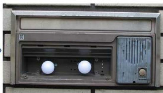
基板を改造し、小型 LED 電球に更新
