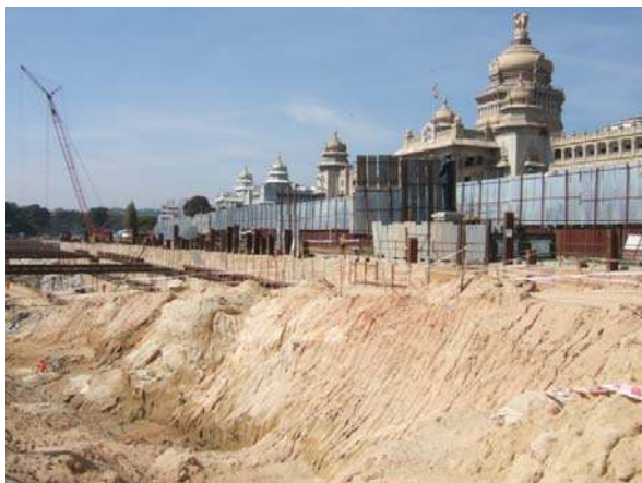
バンガロール地下鉄駅舎開削工事（2011年10月）
