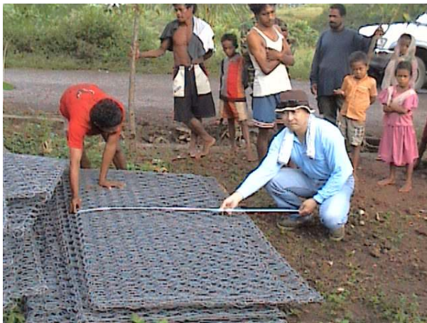
ギャビオン・ネットの検測状況
