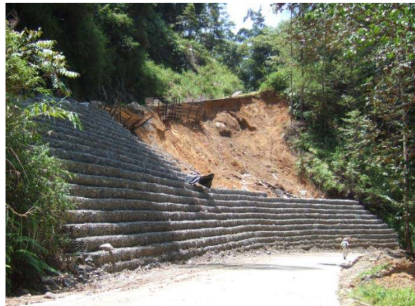
左後方に大規模斜面崩壊を望む（2015年9月） 崩壊斜面をギャビオンで修復
