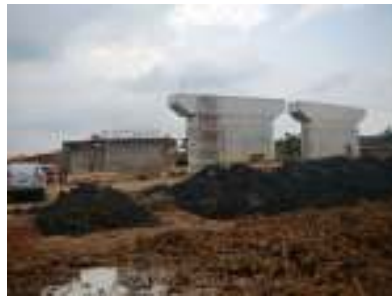
写真-7 橋台と橋脚
