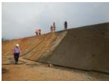
写真-2 膨潤性粘土区間のコンクリート吹付け
