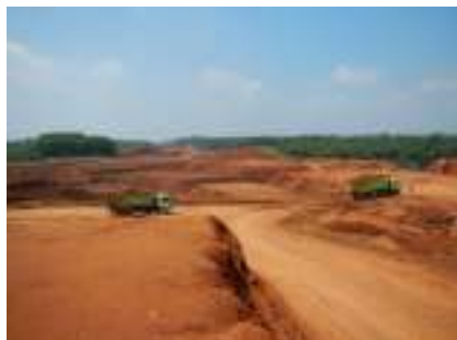
写真-1 土工の様子
