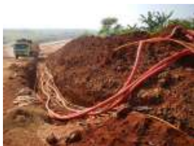
写真-3 既設ケーブルの移設
