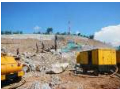
写真-9 岩盤の掘削
