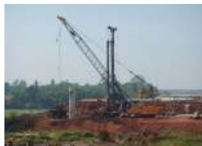
写真-5 杭の施工
