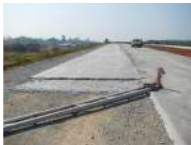
写真-10 土工事の様子
