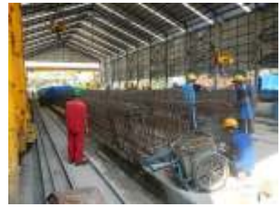
写真-8 橋桁の工場製作
