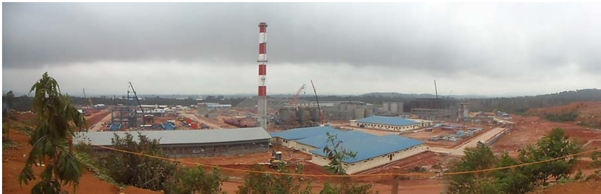
図1 建設現場全景
