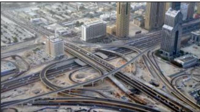
Sheikh Zayed Road のインターチェンジ No. 1。イタリアの建設会社が施工中。既存の高速道路と多数交差する複雑な施工が要求される。
