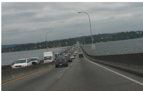
シアトルの浮き橋
