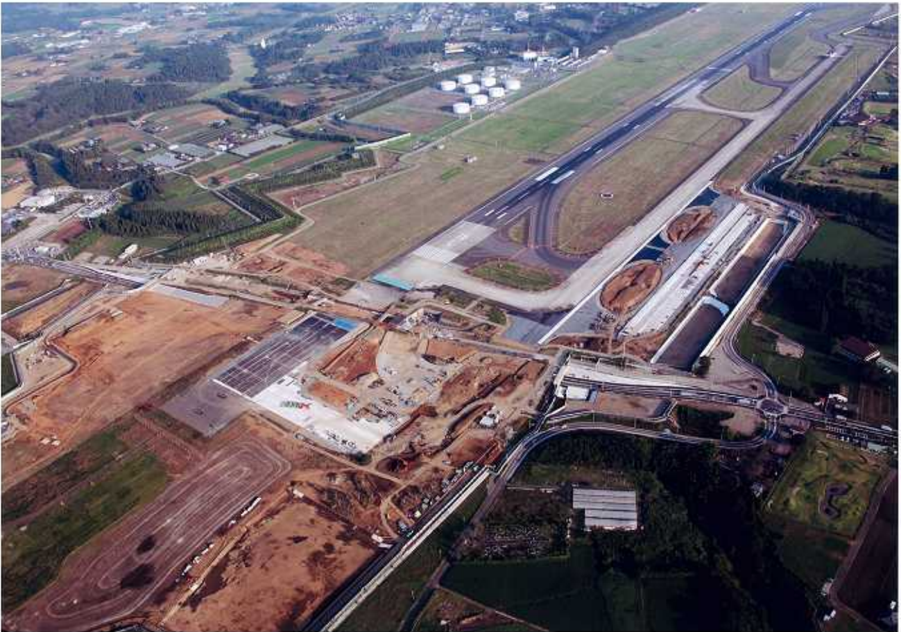
写真： B滑走路延長工事（北西）
