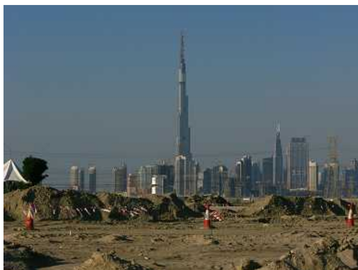
建設中のブルジュ・ドバイ（2008年12月）
