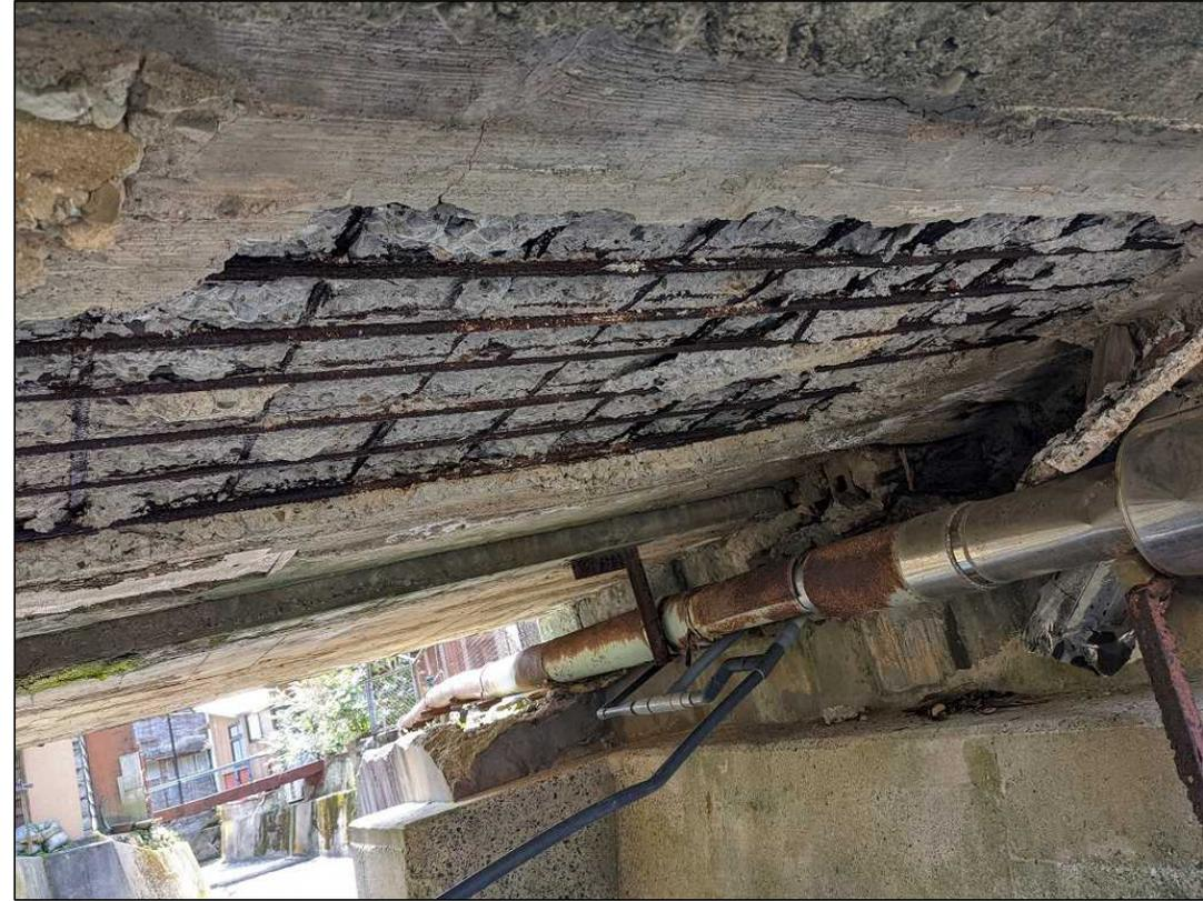
鉄筋腐食→鉄筋断面膨張→コンクリートはく離
